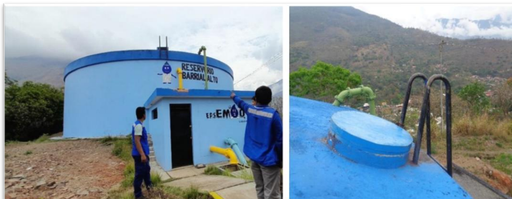
Reservorio apoyado Barrial alta
