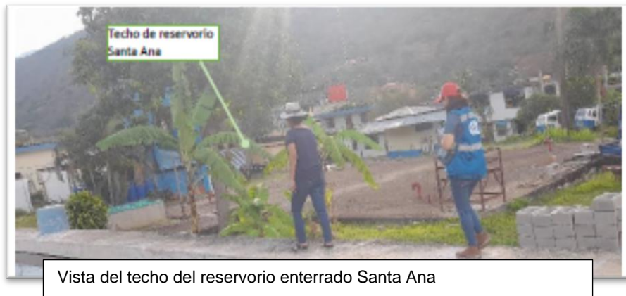
Imagen N°10, Reservorio Enterrado Santa Ana
