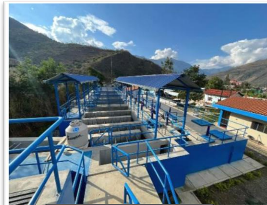
Nueva PTAP Santa Ana
